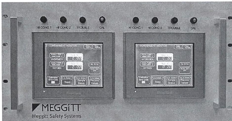
Рисунок 2 – Внешний вид сенсорных дисплеев шкафа обработки данных
